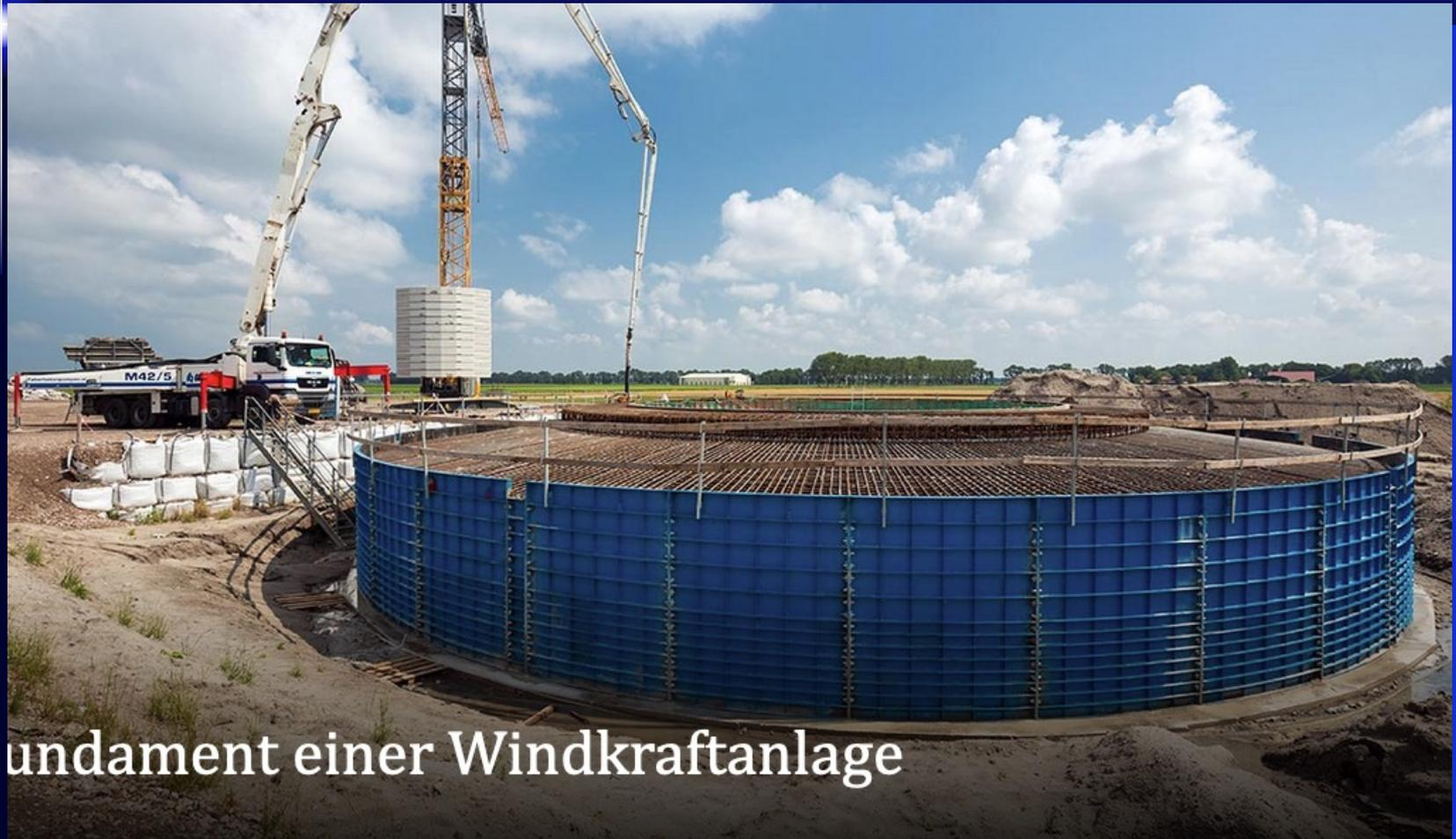
undament einer Windkraftanlage
